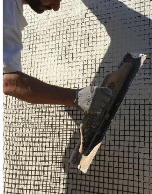
Installazione di Geo Grid 120
