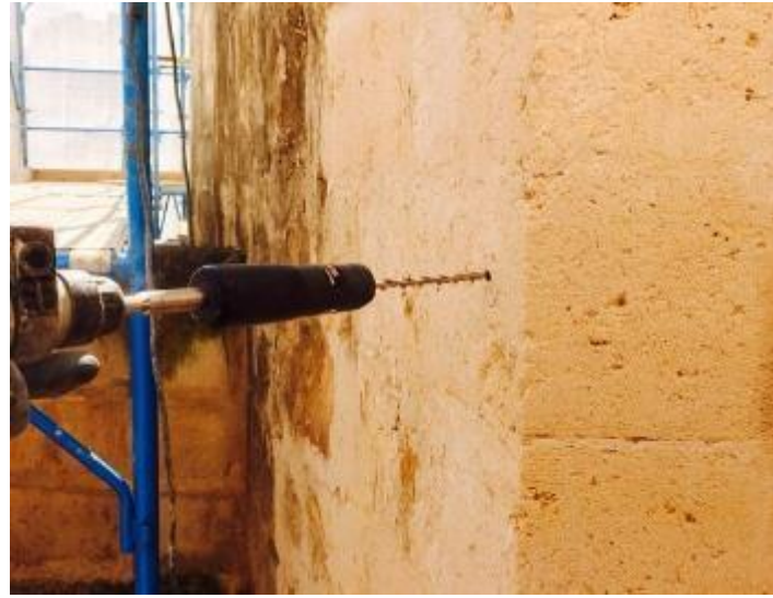
Installazione della barra con Mandrino Steel DryFix
