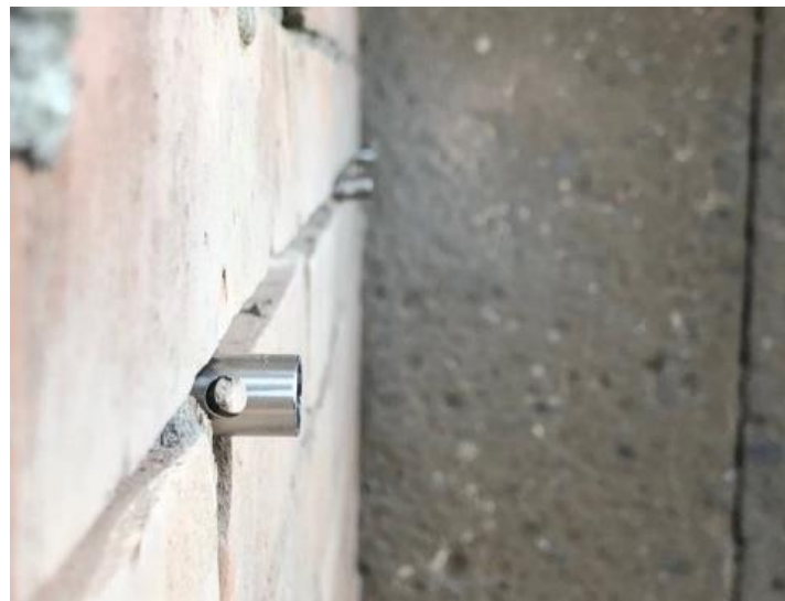
Inserimento del Connettore SteelDryfix
