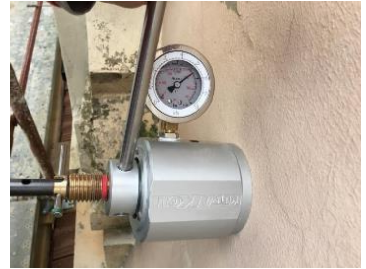
Test di estrazione in situ
