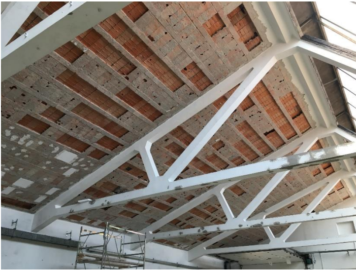
Rimozione elementi decoesi
