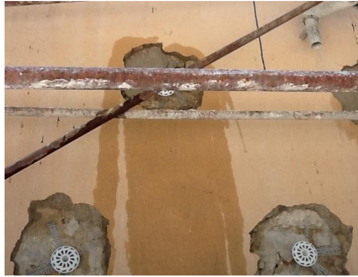
Fiocco GeoSteel G e iniezione di GeoCalce FL
