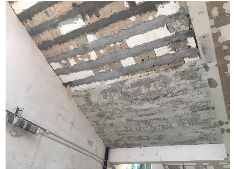
Applicazione presidio con GeoCalce Multiuso e GeoGrid 120
