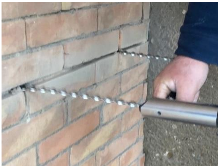
Cucitura con installazione di Steel Dryfix 10
