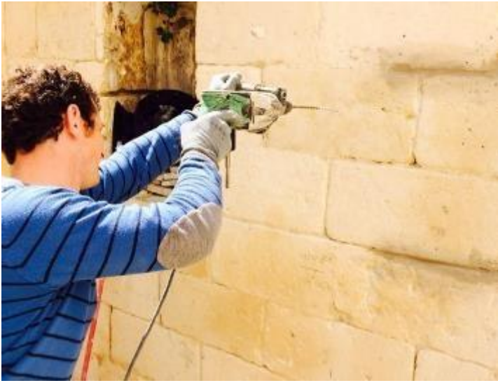
Realizzazione foro pilota di diametro inferiore
