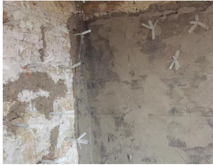
Stesura di prima mano di GeoCalce F e posizionamento di GeoSteel Grid
