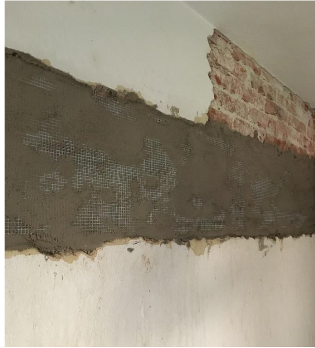
Posa della fascia GeoSteel G
