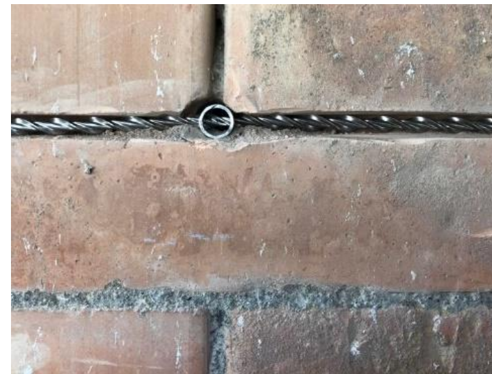
Inserimento della barra Steel Helibar 6
