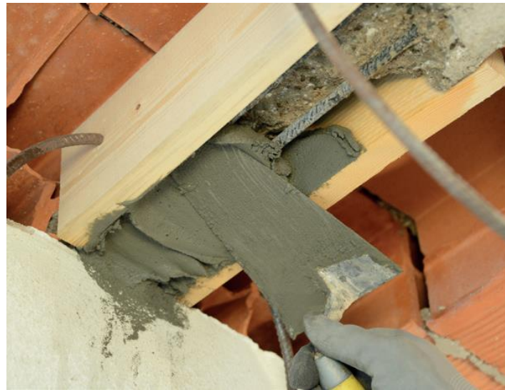
Ricostruzione travetto con GeoLite
